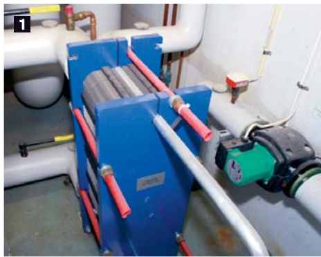
1. En värmeväxlare. 2. Don för behovsstyrd ventilation, VAV. 3. Temperatur- och koldioxidgivare finns i varje lokal i Sunnerbohallen. FOTO: EVA-MARIA FASTH
