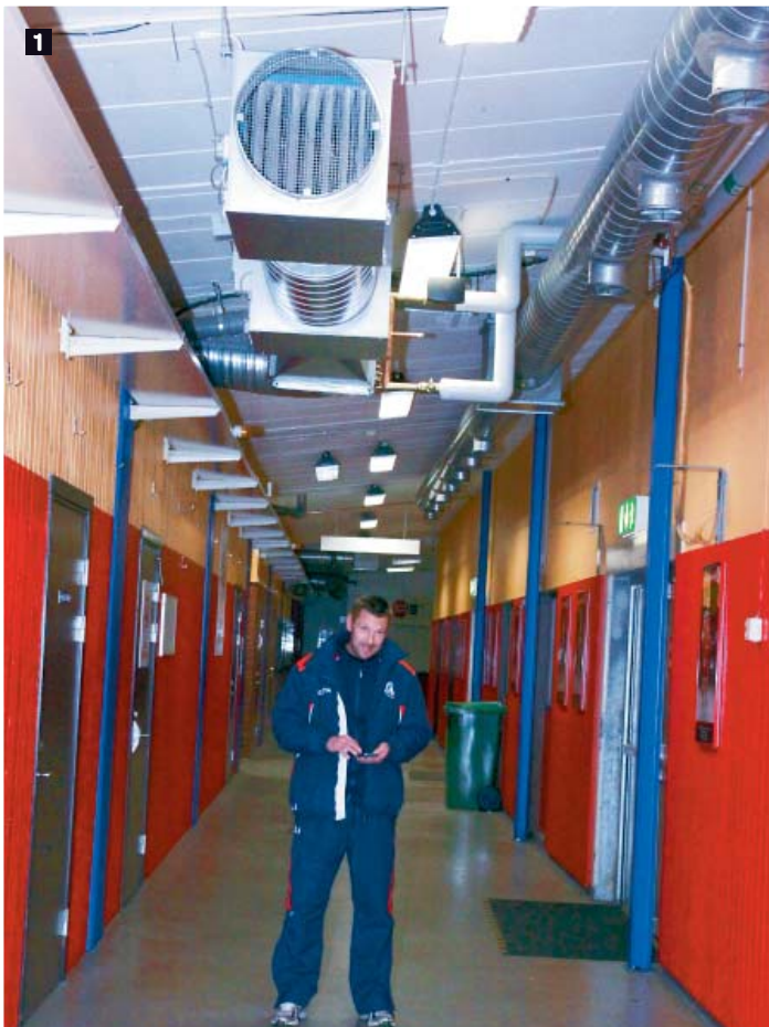
1. FTX-ventilation till och från ishallsens omklädningsrum. 2. Ventilationsrör för FTX i ishallen.
