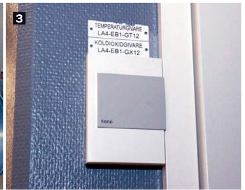
1. En värmeväxlare. 2. Don för behovsstyrd ventilation, VAV. 3. Temperatur- och koldioxidgivare finns i varje lokal i Sunnerbohallen. FOTO: EVA-MARIA FASTH
